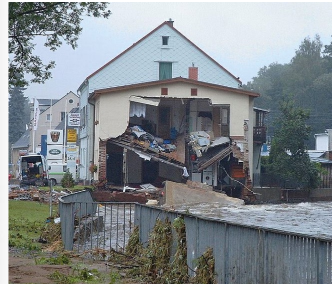
stark beschädigtes Gebäude auf der Grünthaler Straße
