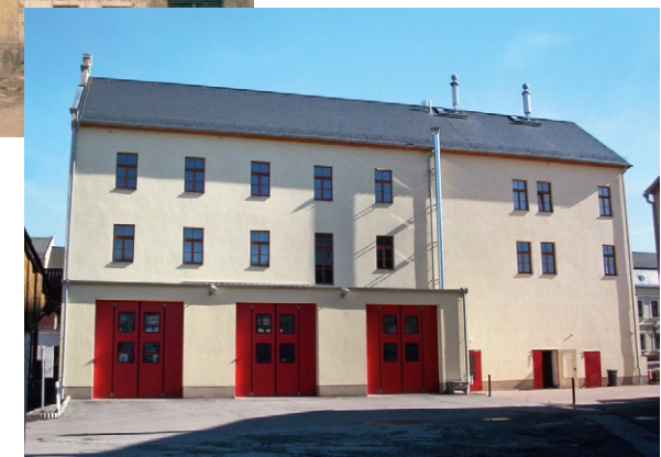
neues Gerätehaus nach Umbau
